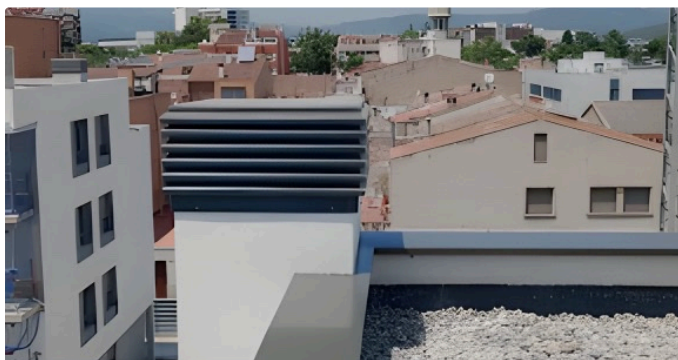
02 Bloque de viviendas — cubremuros RAL 7022 en cubierta transitable
