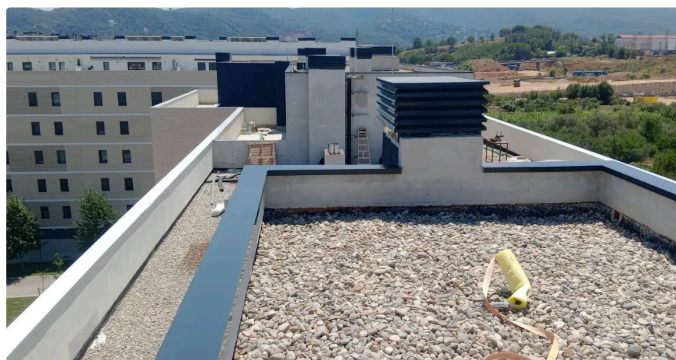
05 Edificio de viviendas — cubremuros ALU-CLICK® y remates de chimenea VENTUM®
