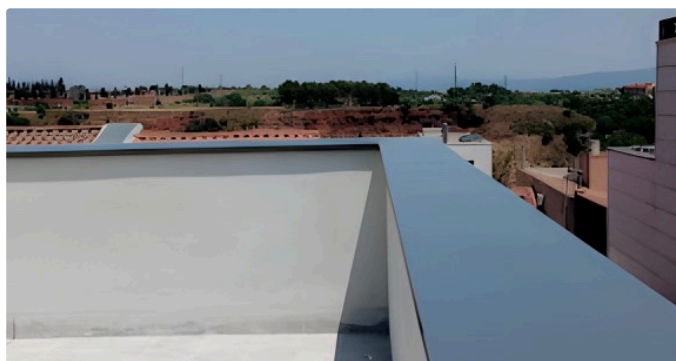
03 Perfil continuo sin juntas visibles, RAL 7022
