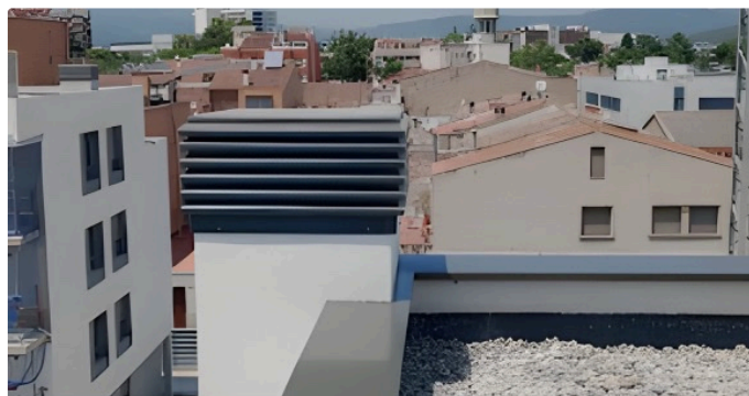
02 Budynek wielorodzinny — obróbka attykowa RAL 7022 na dachu użytkowym
