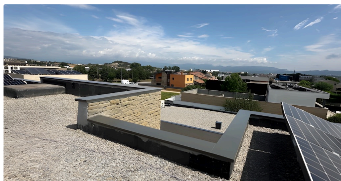
04 Toiture-terrasse — angles et jonctions en T, RAL 7016 anthracite
