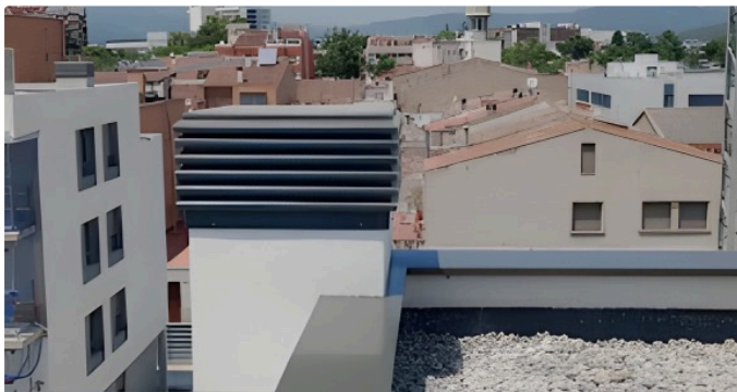
02 Wohnblock — Mauerabdeckung RAL 7022 auf begehbarem Dach
