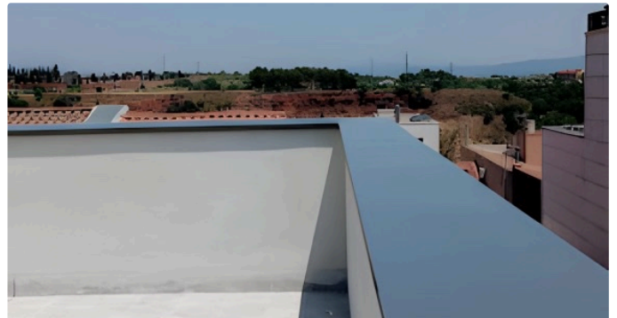
03 Durchgehendes Profil ohne sichtbare Fugen, RAL 7022
