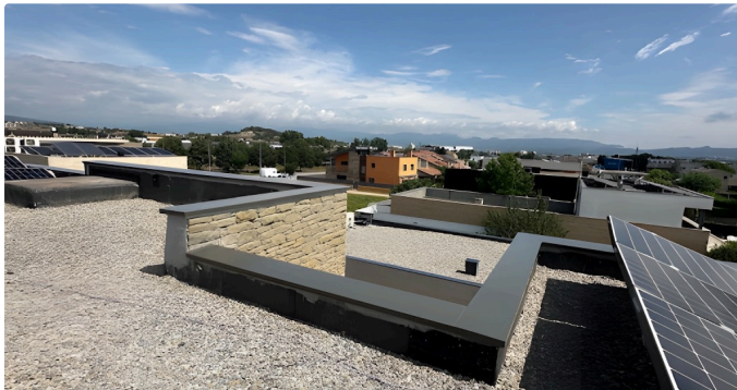
04 Flachdach — Ecken und T-Verbindungen, RAL 7016 Anthrazit
